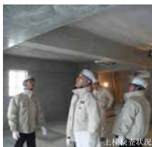
上棟検査状況
