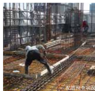
配筋検査状況
