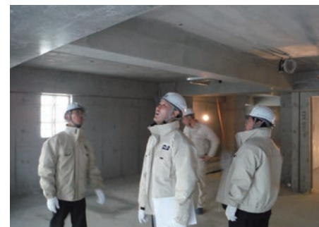
上棟検査状況
