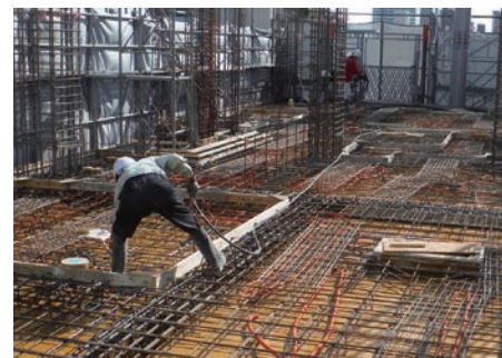
配筋検査状況
