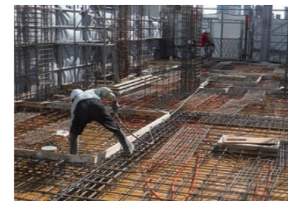
配筋検査状況
