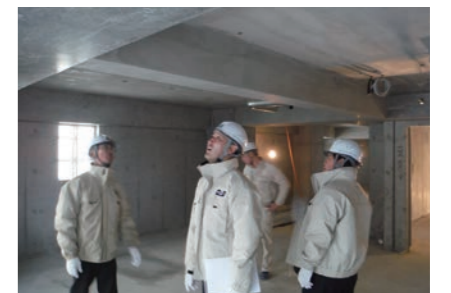
上棟検査状況
