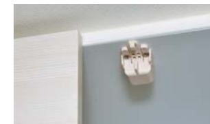
耐震ラッチ 地震時に吊り戸棚の扉が急に開くのを防ぐ耐震ラッチ。食器類の落下を防止し、入居者の安全を守ります。
